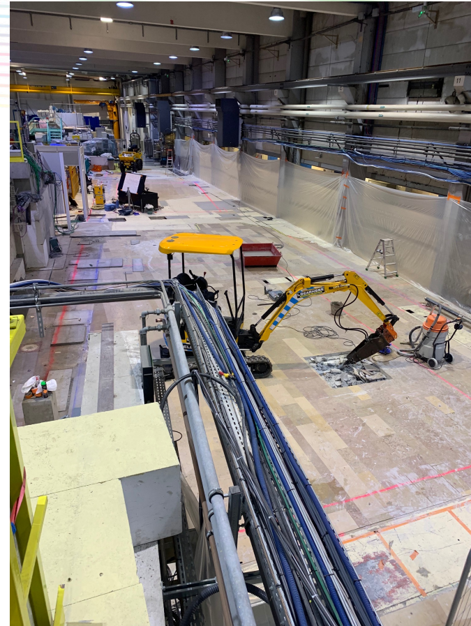
Travaux sur H24
