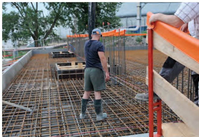
une forêt de ferraille, pour une dalle équivalant à celle d'une tour de 50 étages.
